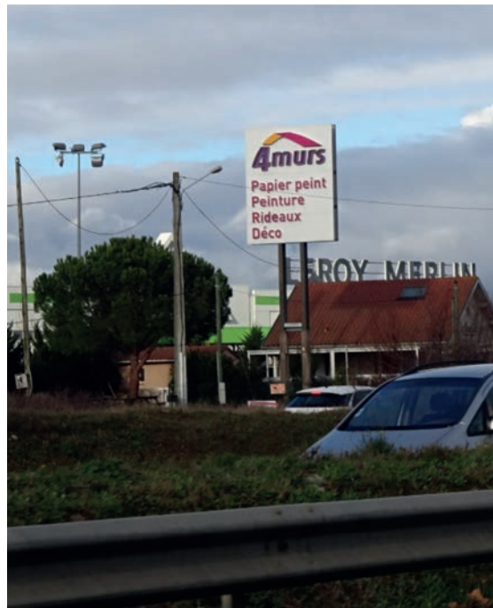
Non-respect de la hauteur maximale autorisée (6,50 mètres) pour une enseigne scellée au sol
